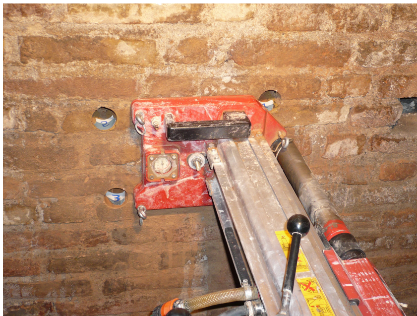
Fig. 3.2: Esecuzione del microcarotaggio su una parete in muratura nella torre.
