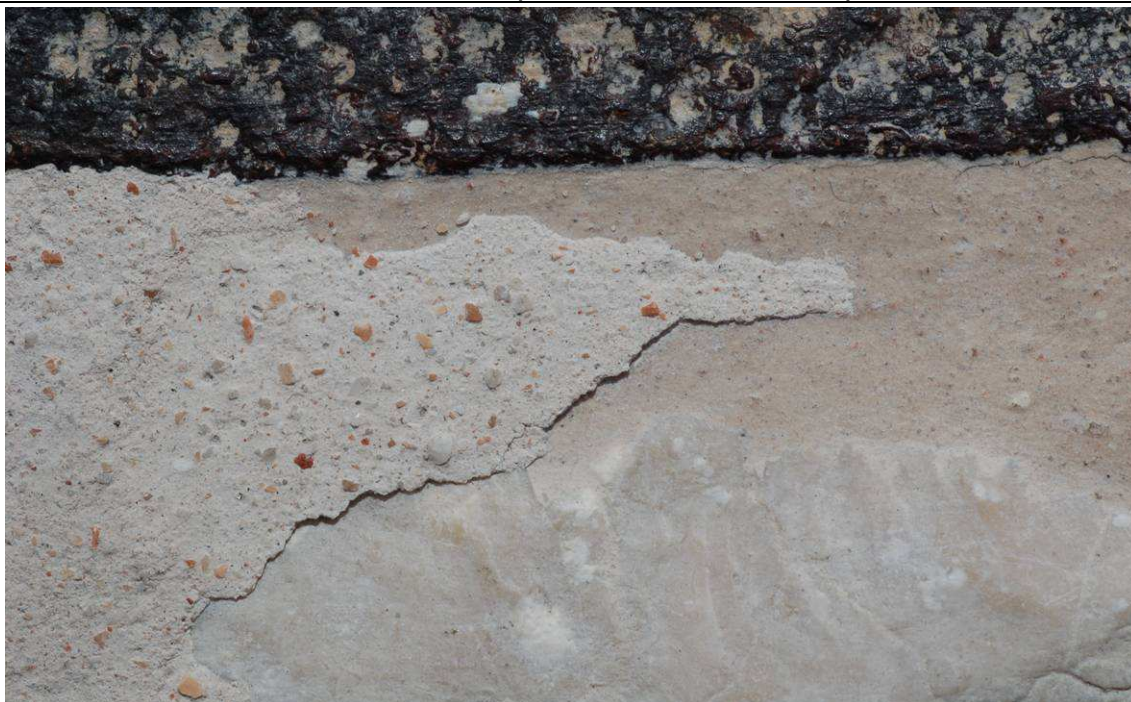
Foto 1 – Stuccatura della cimasa prospetto nord, si notano un principio di distacco della rasatura più superficiale della stuccatura. L'impasto di fondo rimane comunque ben aderito al supporto lapideo.
