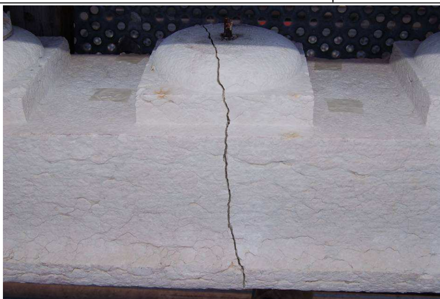
Foto 1: vista generale dell'elemento lapideo, si nota la fessurazione centrale che ne attraversa l'intero spessore
