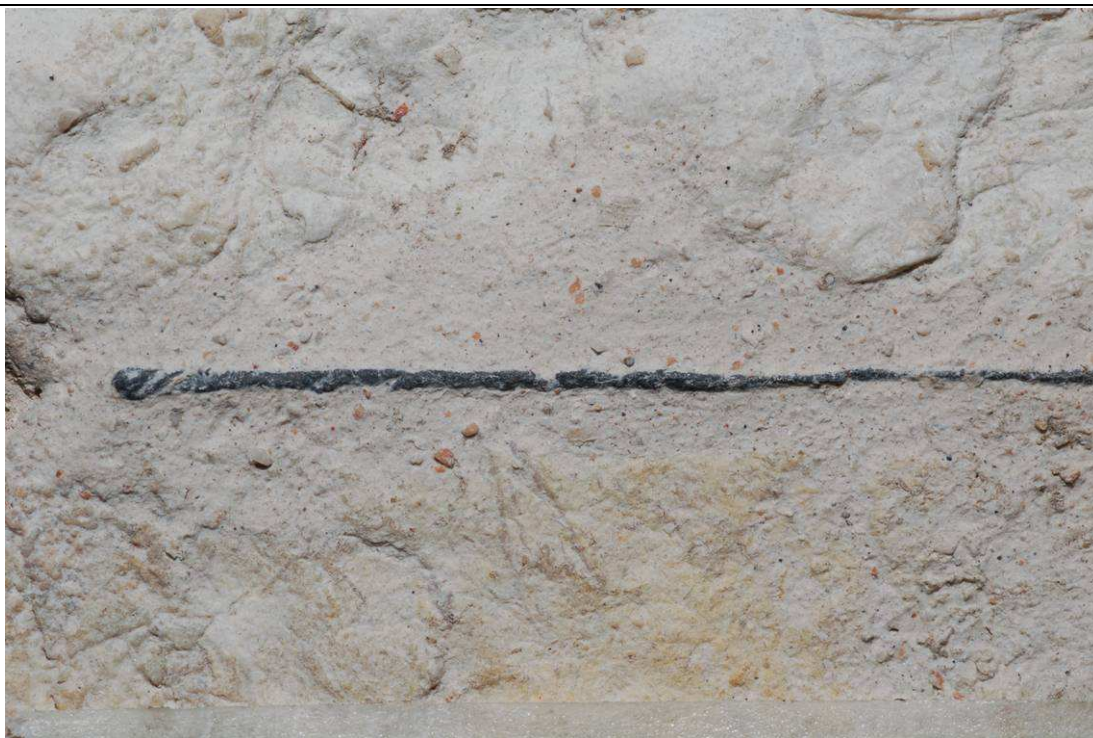
Foto 3 –Marzo 2010, stuccatura con sistema elastomerico in corrispondenza di una porzione in cui dalla giunzione emerge la guaina in biombo.
