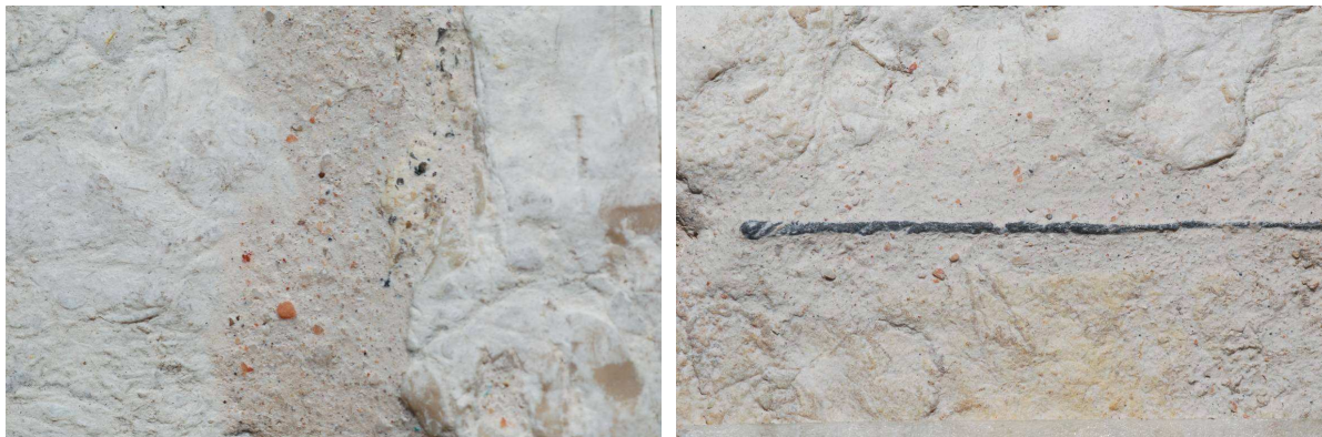
Foto 2, 3 Esempio di stuccature verticali della balastra superiore (a sx) e sigillatura dei giunti tra le lastre di rivestimento della cuspide. Si nota l'ottima continuità tra lapideo e impasto.
