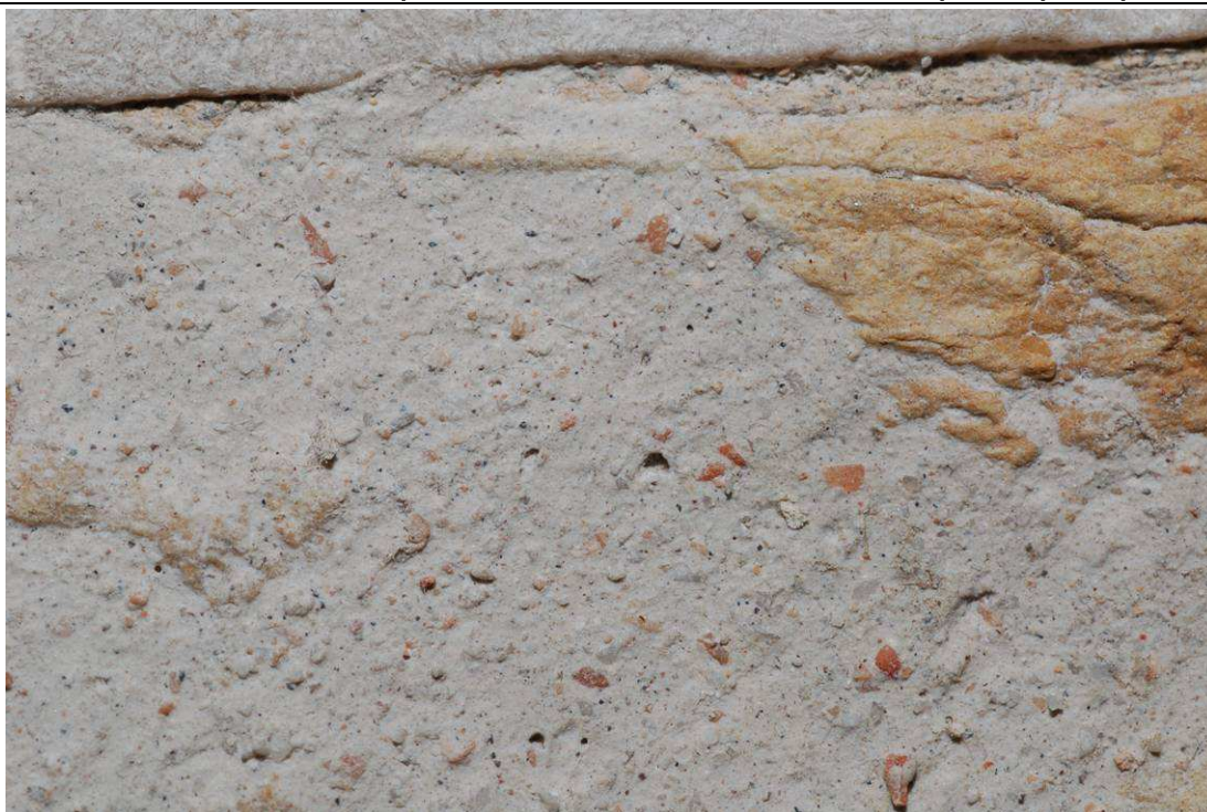
Foto 1 – Settembre 2009, stuccatura integrativa e di giunzione orrizzontale tra due elementi lapidei .
