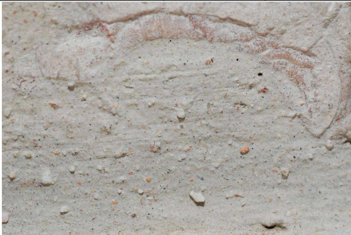
Foto 1 – Stuccatura della cimasa prospetto nord, si notano le buone proprietà coesive della matrice elastomerica e l'ottima continuità con il supporto lapideo.
