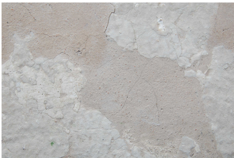
Foto 4: particolare della presenza di microfessure accompagnate da lievi perdite di adesione in corrispondenza di alcune stuccature della balastra superiore.
