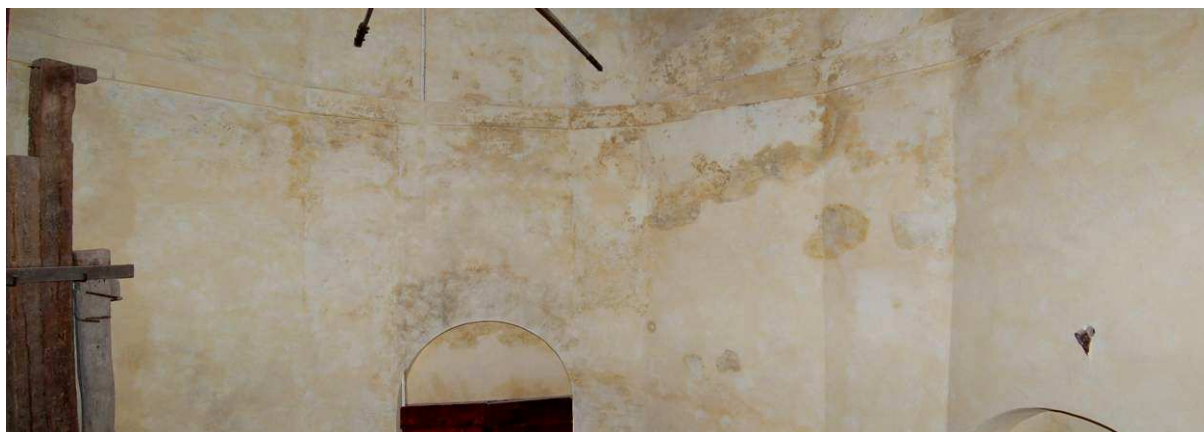
Foto 7: vista generale dell'area del vano scala interessata dai fenomeni di macchiatura dell'intonaco.
