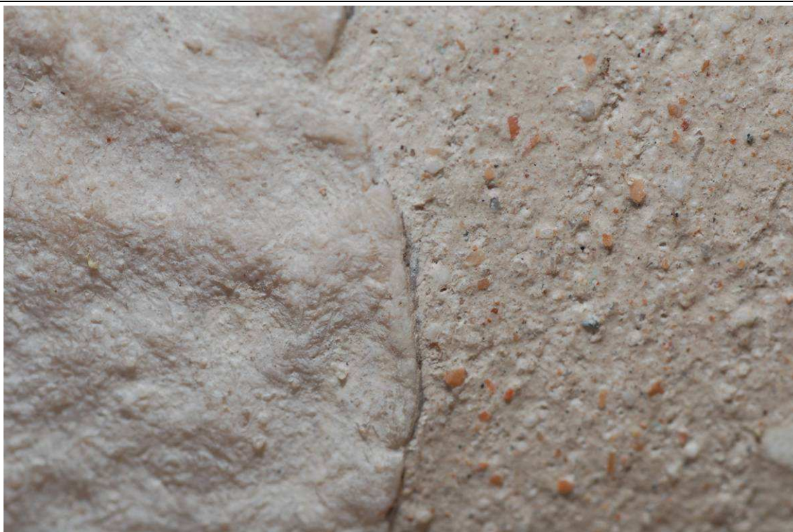
Foto 3 – balastrino sotto cimasa prospetto nord, stuccatura verticale. Si osserva come la buona continuità ed adesione dell'impasto elastomerico al supporto lapideo si siano mantenute pressochè inalterate rispetto alla osservazione effettuata subito dopo il termine dell'intervento (monitoraggio di settembre 2009)
