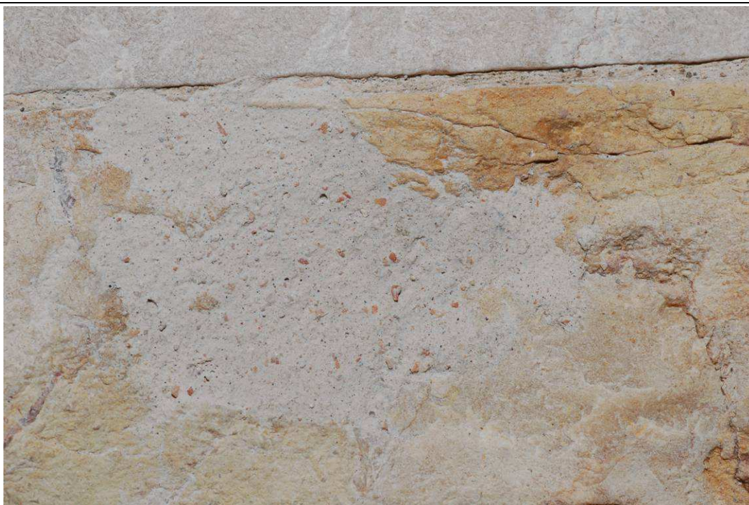
Foto 1 – Marzo 2010, stuccatura integrativa e di giunzione orrizzontale tra due elementi lapidei
