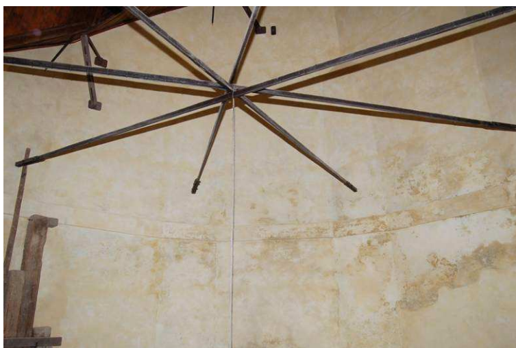
Foto 8 – crociera dei tiranti e particolare zona di macchiatura dell'intonaco
