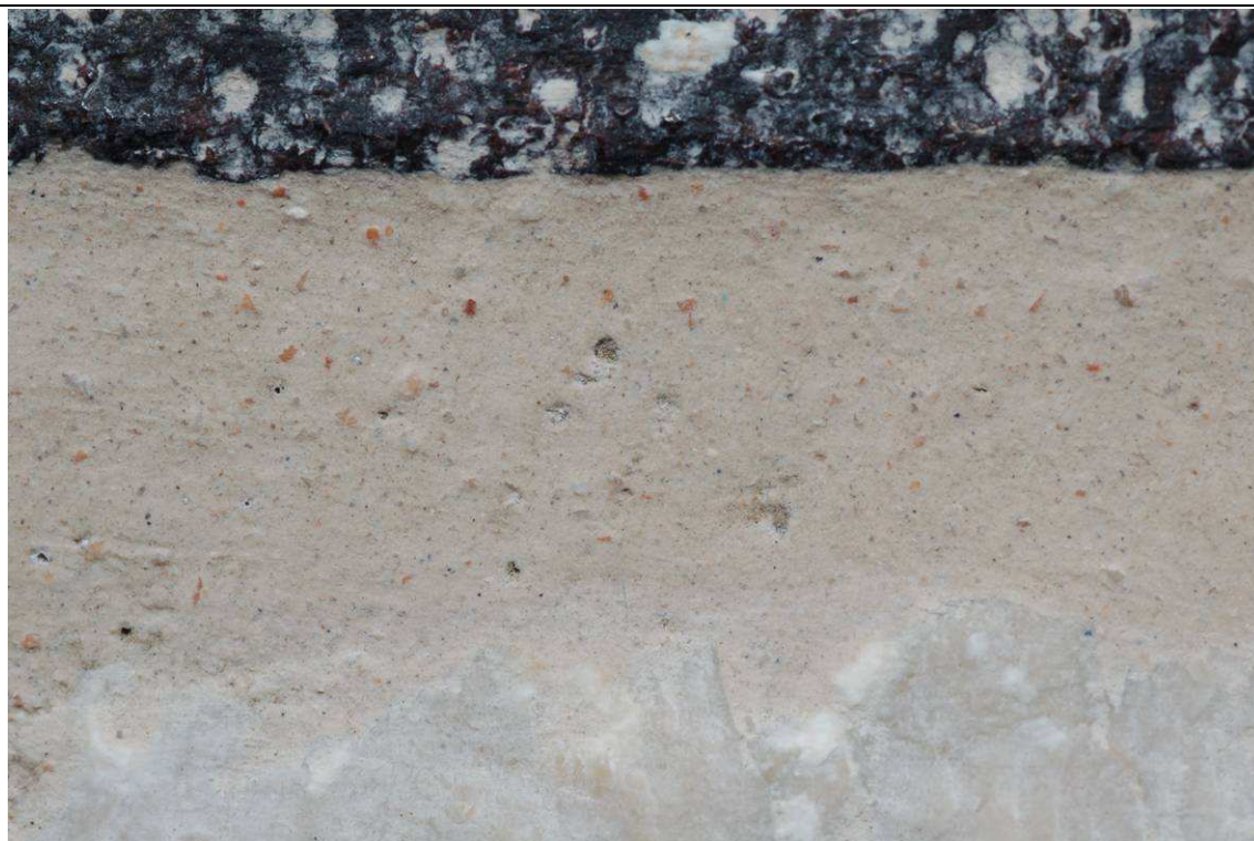
Foto 2 – cimasa prospetto nord, particolare della stuccatura per il riempimento della cavità in cui è fissata la grappa metallica. Continuità ed adesione dell'impasto risultano particolarmente buone.
