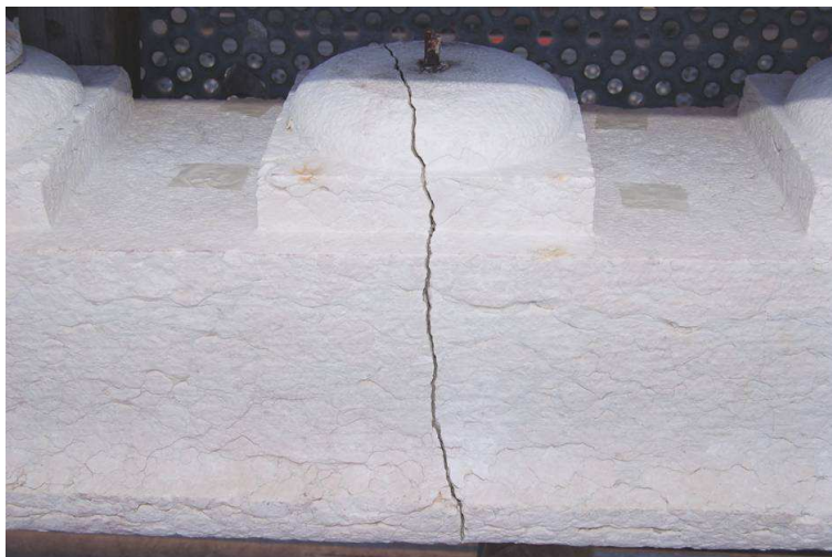
Foto 5, cimasa prospetto nord della balaustra superiore. Particolare della fessura presente prima del restauro
