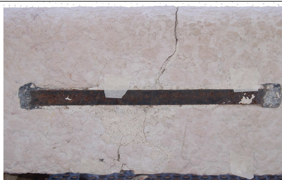
Foto 3: nella parte superiore della cimasa sono presenti una grappa metallica piombata e tracce di una precedente stuccatura.
