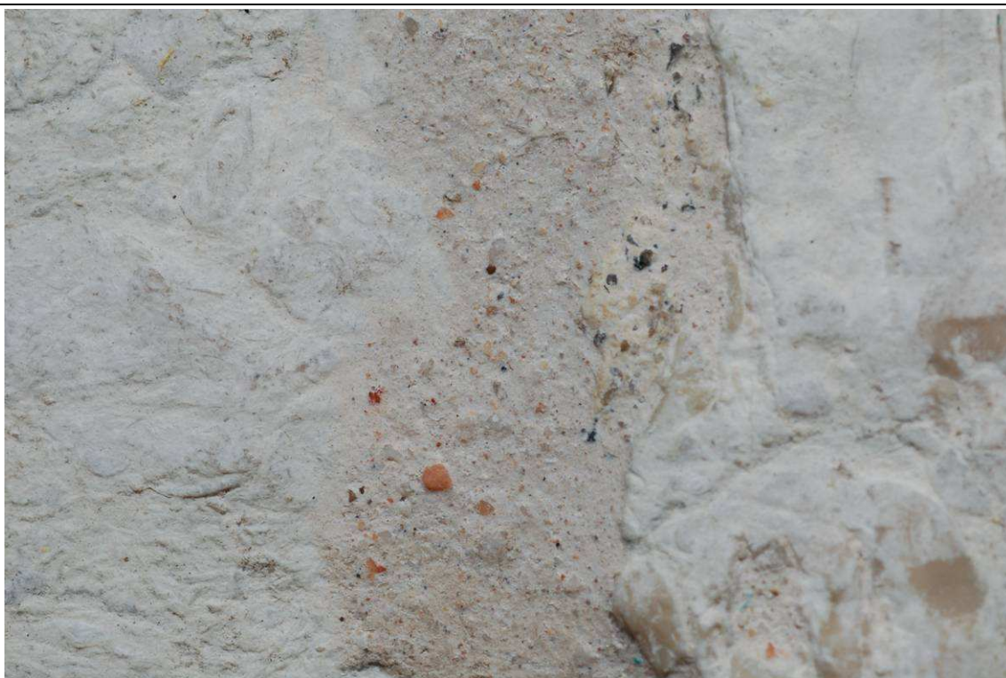
Foto 3 – balastrino sotto cimasa prospetto nord, stuccatura verticale Anche per questo elemento la continuità ed adesione dell'impasto elastomerico al supporto lapideo risultano particolarmente buone.
