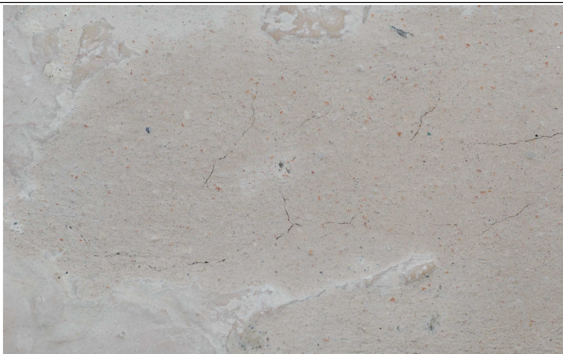
Foto 2 – cimasa prospetto sud, particolare di una stuccatura per il riempimento della cavità . Nonostante il sistema elastomerico continui ad avere una buona continuità con il supporto , si evidenzia la comparsa di un reticolo microfessurativo indicativa di un lieve ritiro della matrice legante, probabilmente acquisito dall'esposizione solare.
