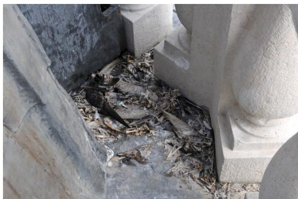
Fig. 8: balaustra superiore, accumuli di resti animali lungo il perimetro calpestabile.
