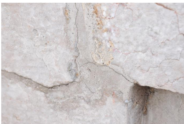
Fig. 8: balaustra superiore, fessurazioni delle stuccature tra le cimase e l'elemento angolare portante, foto di luglio 2012
