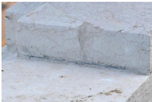
Fig. 9, particolare di sollevamenti e distacchi in corrispondenza di una stuccatura orizzontale.
