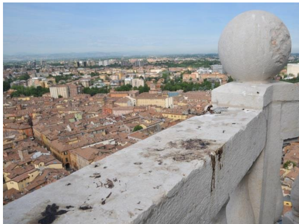
Fig. 6: balaustra superiore, cimasa prospetto sub; si notano i consistenti depositi superficiali
