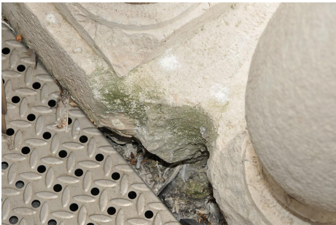
Foto 19: basamenti della balaustrata (prospetto nord), si nota la comparsa di microflora.
