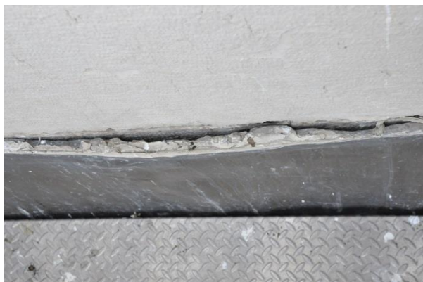
Foto 17: altro particolare di un sollevamento particolarmente accentuato della scossalina nel prospetto ovest.
