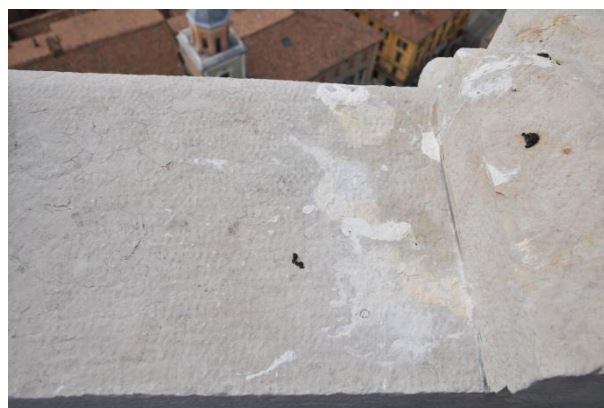
Fig. 1: zona della cimasa interessata da consistenti depositi di guano a causa dei quali si è dovuto spostare la zona di rilievo colorimetrico.
