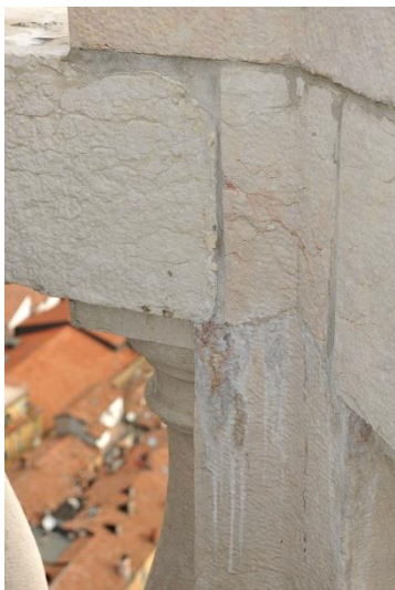
Fig. 7: vista generale della concrezione comparsa tra cimase e pilastro angolare.
