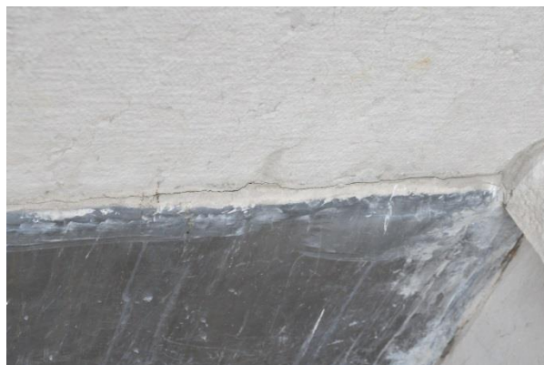
Foto 18: particolare di una zona della scossalina del prospetto sud, in cui si osserva la sola fessurazione della stuccatura.
