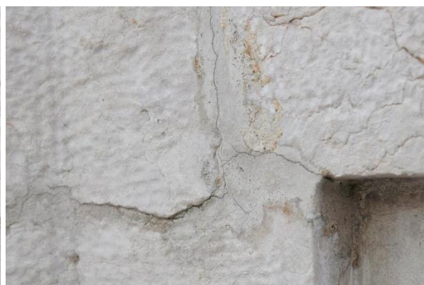
Fig. 13: balaustra superiore, fessurazioni delle stuccature tra le cimase e l'elemento angolare portante, foto di luglio 2013
